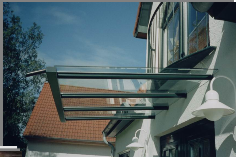
Objekt (010601): Stahl, feuerverzinkt, grün pulverbeschichtet, in Wand eingelassen, VSG-Scheiben klarer mit Folie.
