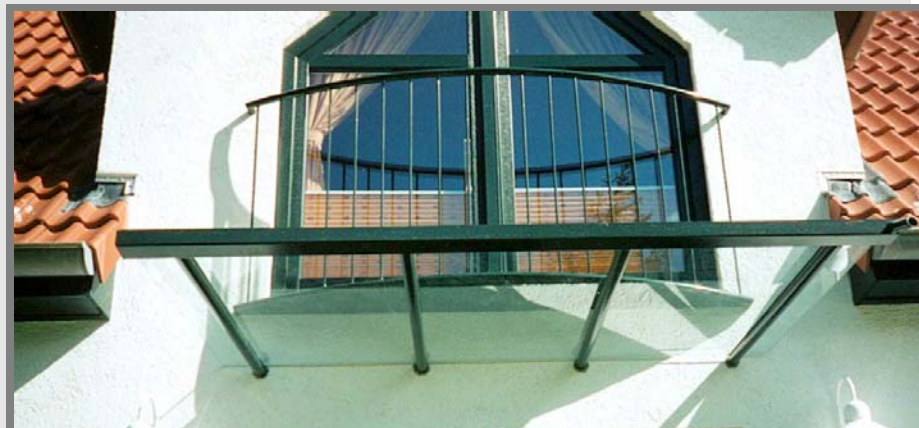
Objekt (010601): Stahl, feuerverzinkt, grün pulverbeschichtet, in Wand eingelassen, VSG-Scheiben klarer mit Folie.
